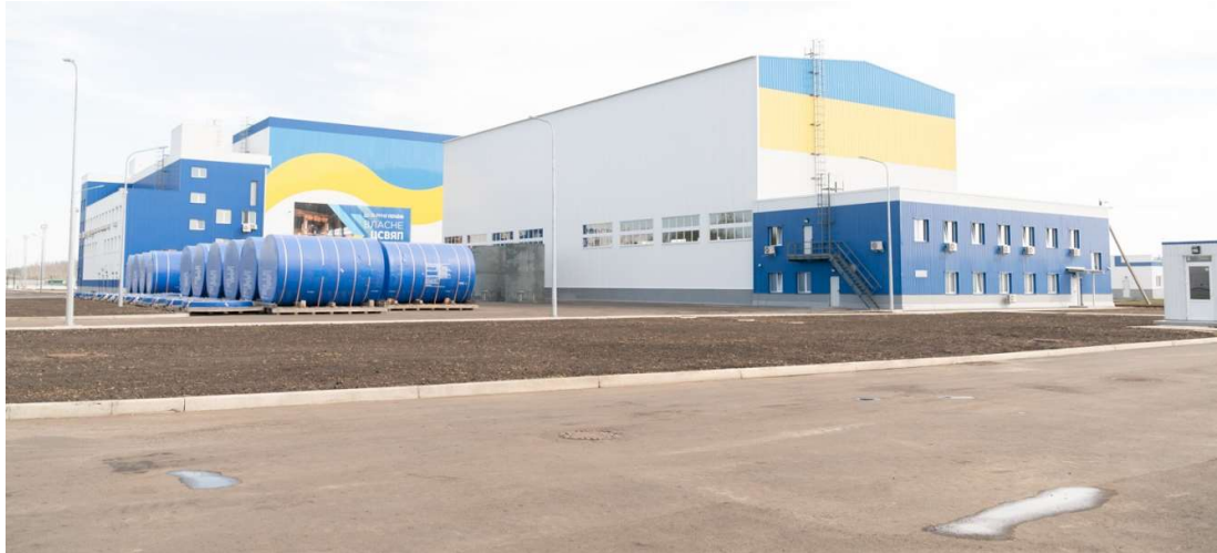
Майданчик ЦСВЯП (будівля техобслуговування, будівля приймання)
