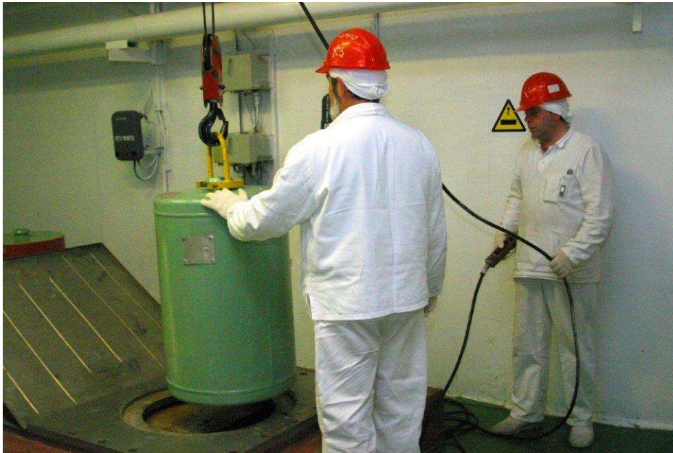
Стропування контейнера з СП
