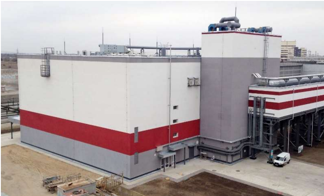
Будівля КПРАВ ЗАЕС
